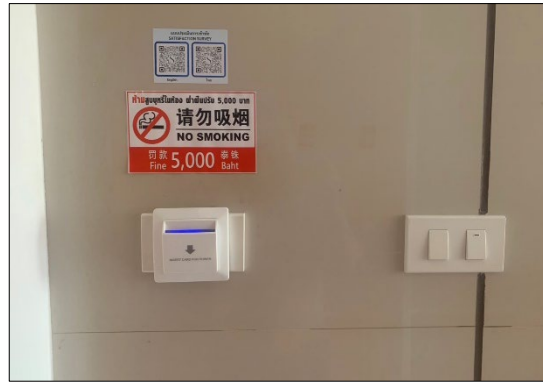
รูปที่ 3.2-25 ระบบ access control ด้วยระบบ keycard และระบบ control การใช้พลังงานภายในห้องพัก
